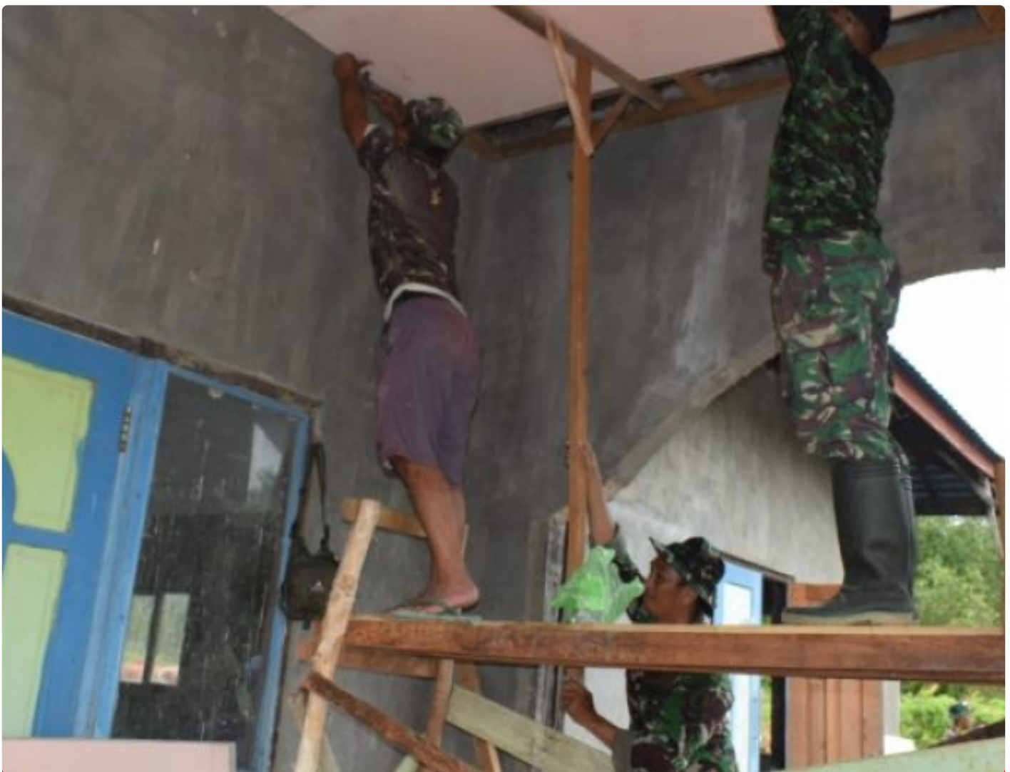
Anggota Satgas tMMD Pasang Plafon Masjid
